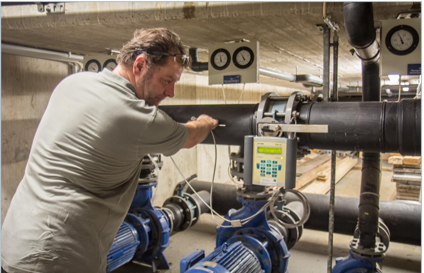
Volumenstrommessung an der Druckleitung eines Strömungskanal
